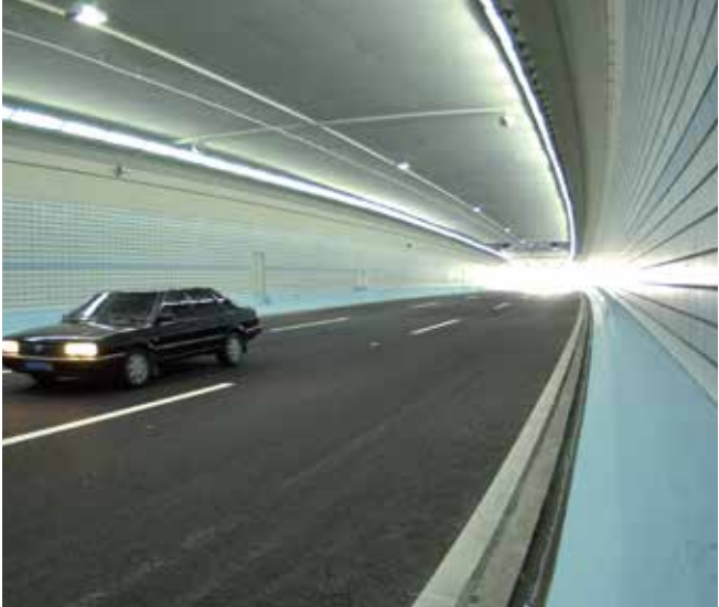
>> 上海外环线隧道工程
