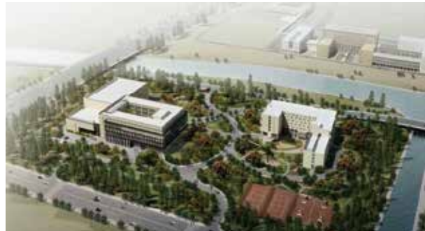
中国人民银行支付系统上海中心工程
