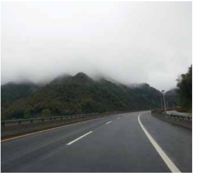
>> 金寨县小南京公路工程
