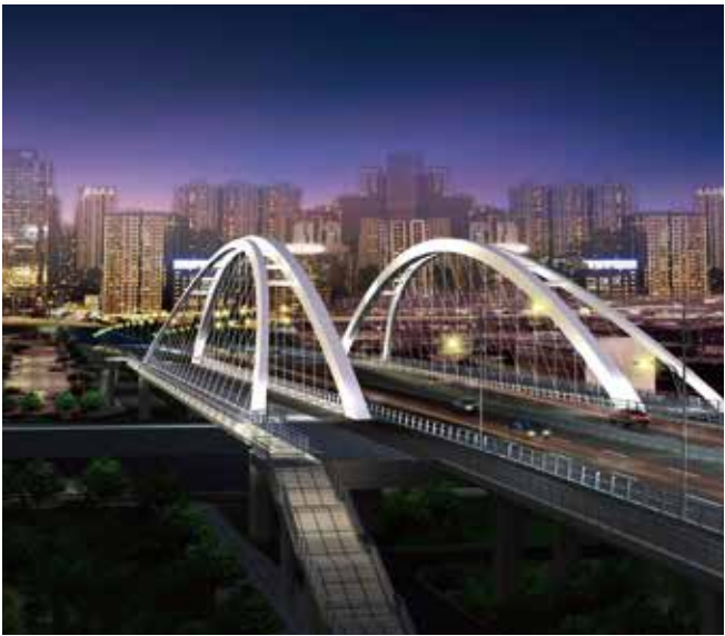
>> 康宁路桥工程
